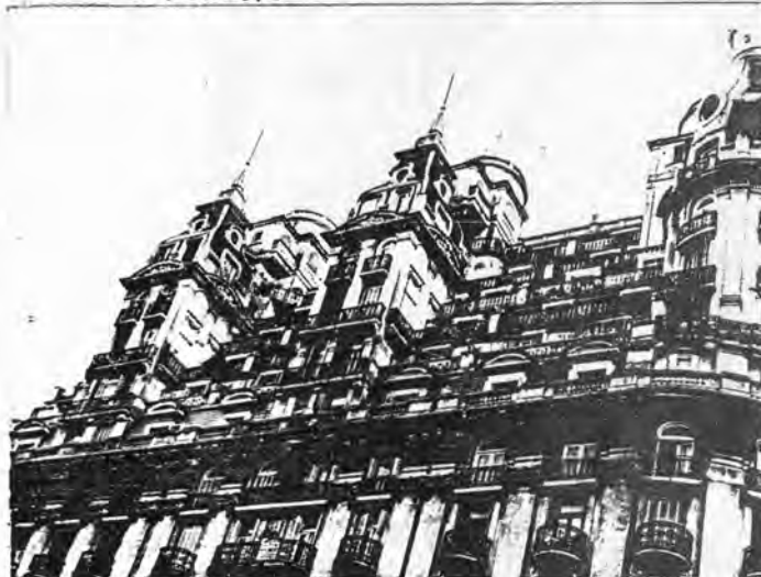
-Esquina del edificio Bencich (Córdoba y Esmeralda.).
