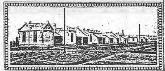
Colonia del departamento de locomotoras. Talleres Banfield. Casas de 3ra. clase para familias - 1901
